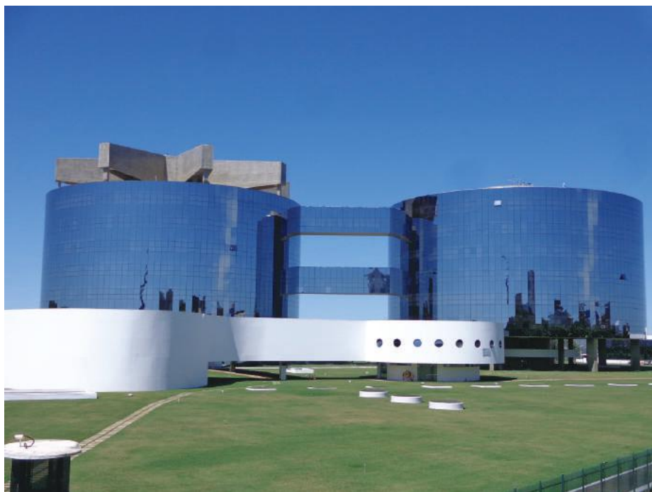
Figura 3. Visão do conjunto arquitetônico da Procuradoria Geral da República, em Brasília. A película que reveste os vidros não é azul, podendo refletir todo o espectro. Como a fotografia foi obtida em um dia claro e sem nuvens, a imagem refletida do céu forneceu a tonalidade azulada.
