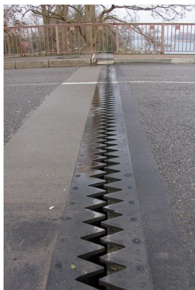
Figura 7 - Junta de expansão em uma ponte. Fonte: www.wikiwand.com/en/Thermal_expansion . Acesso em 10/12/2020.
