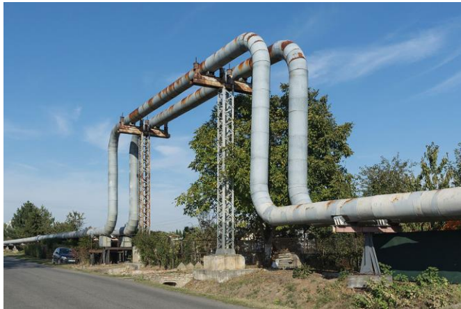
Figura 6 - Laço de expansão térmica em tubulação de óleo. Fonte: www.wikiwand.com/en/Thermal_expansion . Acesso em 10/12/2020.
