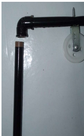
Figura 59 - Fixação do cano de suporte ao joelho de 90°.
