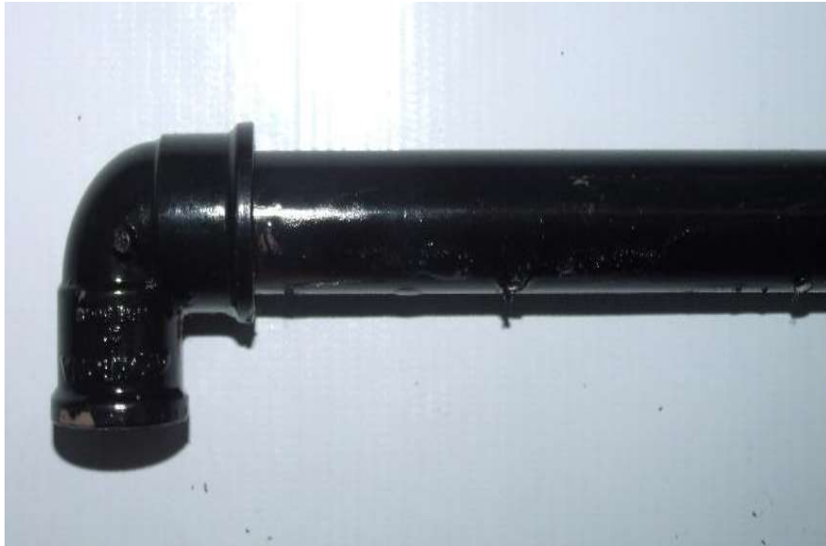
Figura 54 - Colocação do joelho de 90° ao cano.
