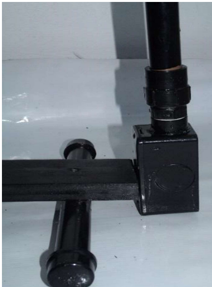
Figura 51 - Cano fixo na caixa de condutele.
