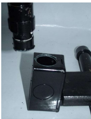
Figura 50 - Colocação do cano a caixa do condutele.
