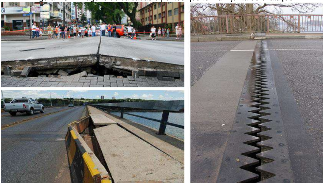
Figura 4.3 – Imagens de calçadas e pontes que tenham junta de dilatação
