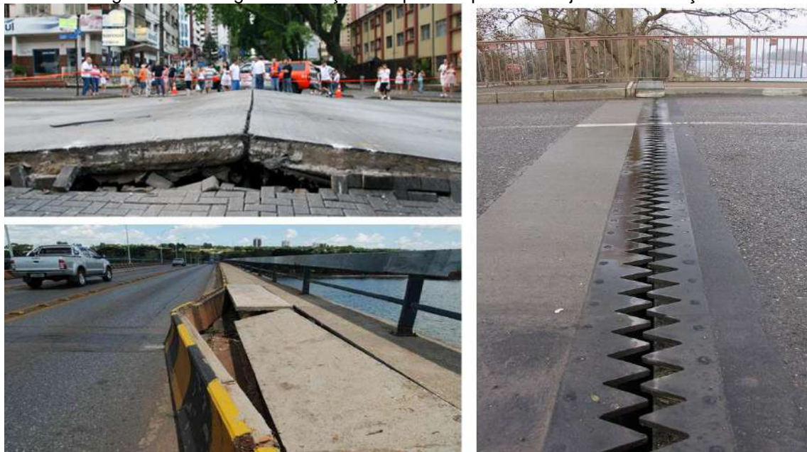
Figura 5.3 – Imagens de calçadas e pontes que tenham junta de dilatação
