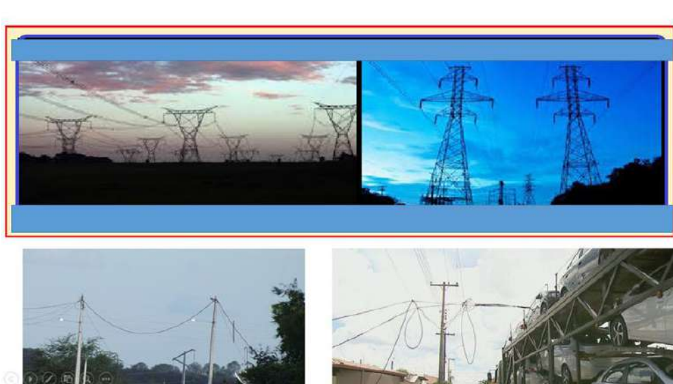
Figura 4.1 – Imagens de fios que conduzem eletricidade
